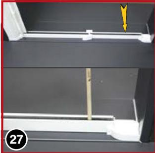
Richten Sie die untere Führungsschiene exakt aus und markieren Sie die Bohrstellen.
