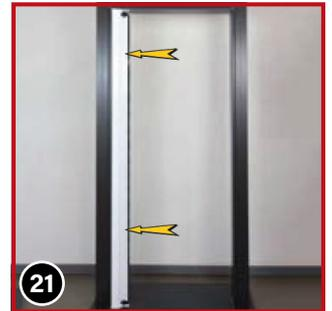
**TIPP** Ab hier am besten zu zweit arbeiten. Bringen Sie den ersten Rollokasten in die exakte Position. Durch die Klemmfeder (31) lässt sich der Kasten dabei etwas einklemmen.
