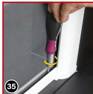
Schrauben Sie dann die untere Führungsschiene mit den Schrauben 4x40 in der Türleibung fest.
