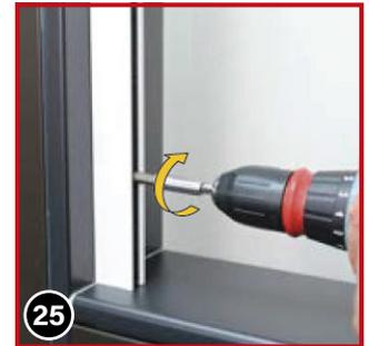
Wenn die Führungsschiene exakt positioniert ist, diese mit den Schrauben 4x40 anschrauben.
