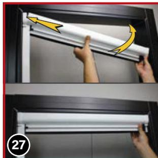
Rollokasten mit aufgesteckter Endkappe DX/R (10) in die bereits verschraubte Endkappe einstecken. Rollokasten an die exakte Position bringen.
