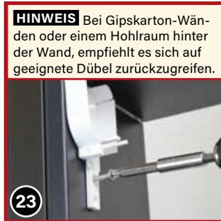
**HINWEIS** Bei Gipskarton-Wänden oder einem Hohlraum hinter der Wand, empfiehlt es sich auf geeignete Dübel zurückzugreifen.
