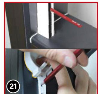
21 Markieren Sie die Bohrstellen für die Befestigung der Führungsschiene und Endkappe (10). Bei der Endkappe im oberen Bereich reicht es aus, wenn Sie diese im mittleren (länglichen) Loch anschrauben.
