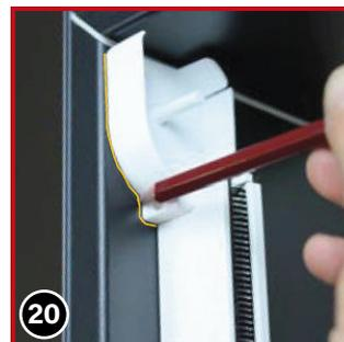
20 **TIPP Ab hier ist eine zweite Person hilfreich.** Fahren Sie mit einem Stift den Rand der Endkappe (10) an der Leibung nach, damit Sie beim Anschrauben genau wissen, wo diese nach dem Bohren angeschraubt werden muss.
