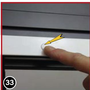
Jetzt in die großen Bohrlöcher der Führungsschienen und des U-Profils die Bohrungsabdeckstüpsel (32) einsetzen.
