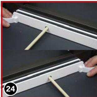
Markieren Sie die Bohrstellen und entfernen Sie die Schiene.
