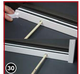
Markieren Sie die Bohrstellen und entfernen Sie die Schiene.
