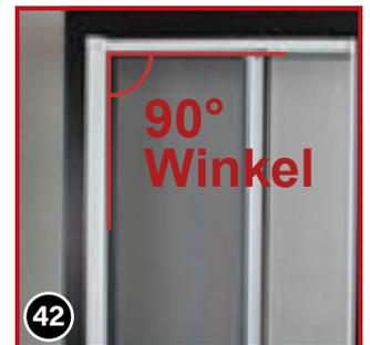
**ACHTUNG** Überprüfen Sie vor dem nächsten Montageschritt, ob sich der Kasten und das U-Profil zu den Führungsschienen im 90° Winkel befindet!
