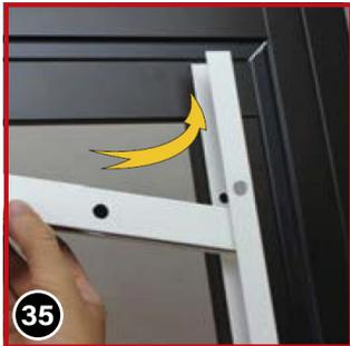
35 Auf der anderen Seite stecken Sie die Führungsschiene in die Nut des U-Profiles.
