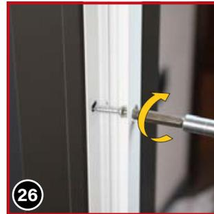
Das U-Profil mit den Schrauben 4x40 in den Dübeln/den vorgebohrten Löchern befestigen.
