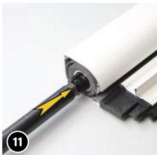
Schieben Sie das Lager links mit Feder ① soweit auf der anderen Seite des Rollokastens ein, bis die Feder noch ungefähr eine handbreit aus dem Kasten raus steht. **TIPP** Erledigen Sie den nachfolgenden Schritt am besten an einer Tischkante.
