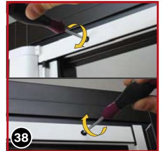
38 Befestigen Sie nun die obere Führungsschiene genauso, wie in den Montageschritten (31) und (32) für die untere Führungsschiene erklärt.
