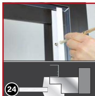
Stellen Sie nun das U-Profil mit der Nut näher nach innen (in welcher auch die Haken (21) eingeschoben sind) so hin, dass es am Türrahmens oder der Wandleibung abschließt.
