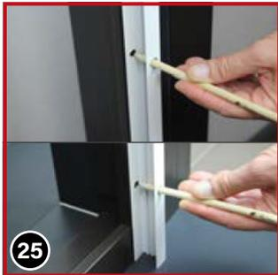
Markieren Sie die Bohrstellen und entfernen Sie das U-Profil.
